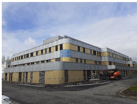
Vue de la façade arrière
