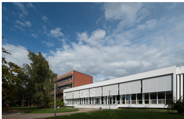
Vue de l'entrée principale du bâtiment
