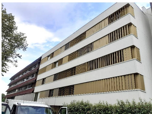
Vue extérieure bâtiment D'Alembert - (chantier en cours)
