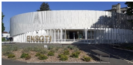
Entrée bâtiment Ferry après les travaux
