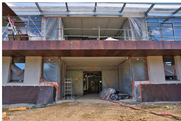
Vue de l'entrée principale du bâtiment
