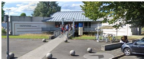
Entrée bâtiment Ferry avant les travaux
